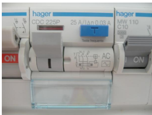
Figura 3 - Disjuntor Diferencial (RCD) de elevada sensibilidade ( I_n \leq 30\text{mA} ) instalado num quadro eléctrico de uma habitação, a proteger as tomadas em locais húmidos
